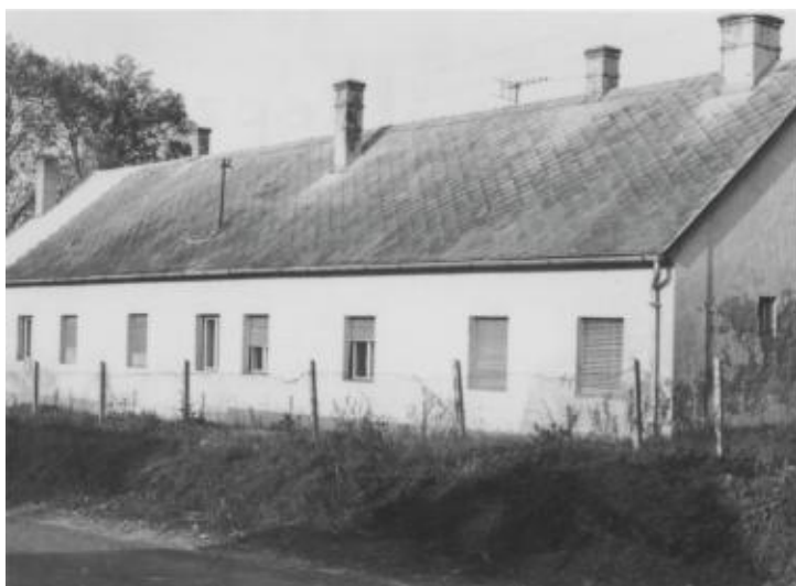
A felnőtt szállás épülete
